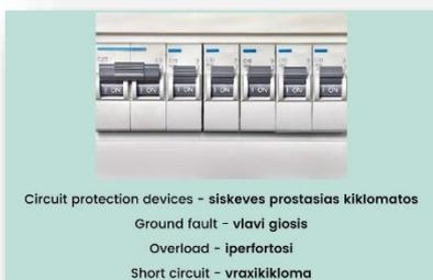
Connaitre l'emplacement et le fonctionnement des dispositifs de protection des circuits **siskeves prostasias kijklomatos**. Les dispositifs de protection des circuits sont conçus pour limiter ou couper automatiquement le flux d'électricité en cas de défaut de terre **vlavi giosis**, de surcharge **iperfortosi** ou de court-circuit **vraxikikloma** dans le système de câblage.
